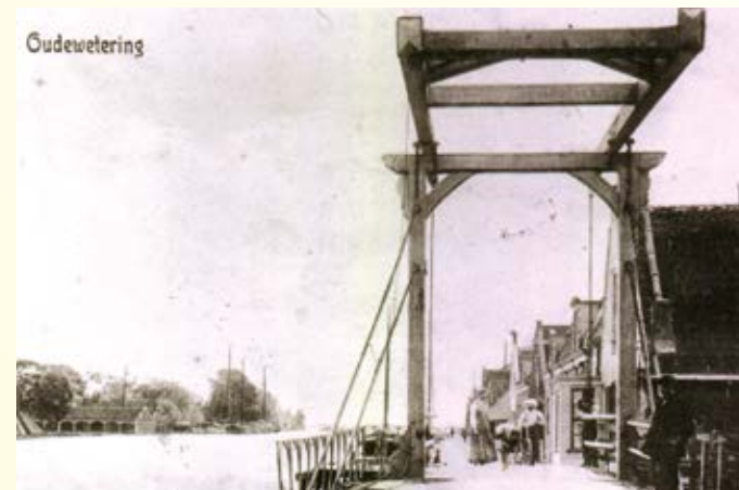
De sluisbrug tussen de Kerkstraat en de Veerstraat.
